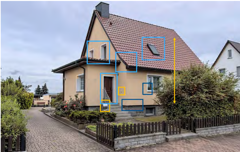
Abbildung 3.3: Gebäudebeispiel zur Validierung der Methodik, hier: Einfamilienhaus (gelbe Markierung), 1. WSVO (hellblaue Markierung), Saniert (dunkelblaue Markierung), Quelle: Foto aus [10]
